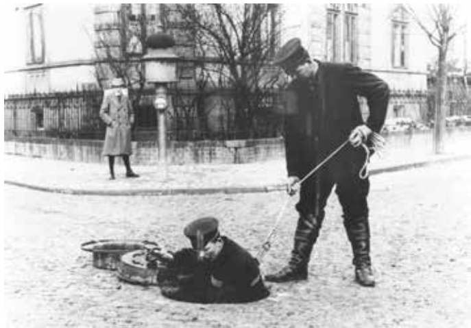
1867 hatte der Bau der Kanalisation begonnen.
